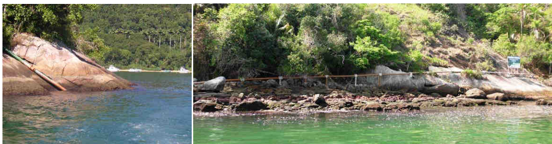
Figura 16 Dentre as obrigações de fazer da Sentença Judicial, cumpridas pela Empresa, está o prolongamento da tubulação de modo que os efluentes da ETE não sejam mais lançados diretamente na ESEC Tamoios. Fotos de Antes e Depois da Intervenção.
