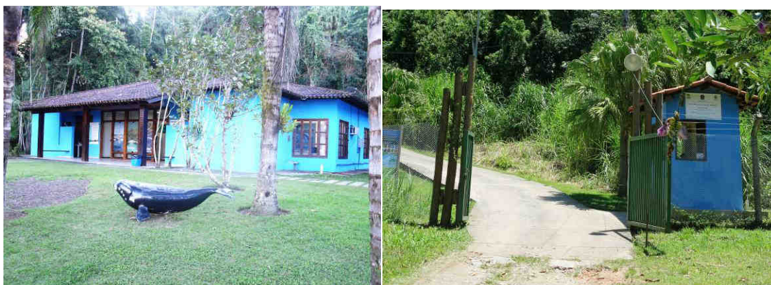
Figura 2 Sede Administrativa reformada e Guarita construída em 2013 de Tamoios
