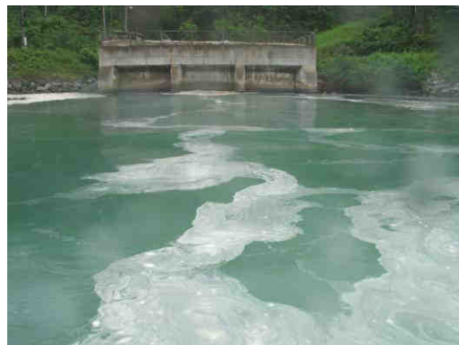
Figura 25 Espuma escoada dos suspiros da tubulação da Saída d'água de resfriamento e sendo lançada na Saída d'água de resfriamento das usinas
