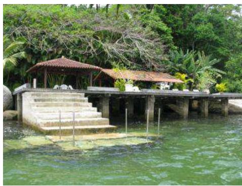
Figura 27 Edificação de veraneio com deck e escada sobre área marinha da ESEC Tamoios
