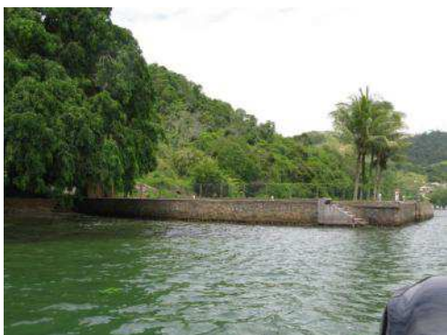
Figura 26 Aterro com muro de contenção, ocupando aproximadamente 1000 m 2
