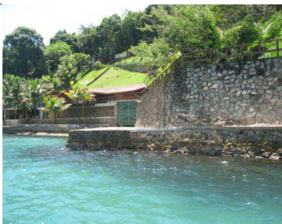
Figura 49 Muro de contenção sobre a costeira
