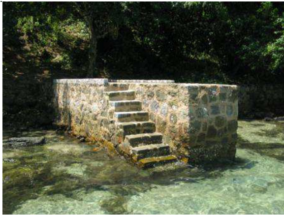
Figura 45 Cais em pedra
