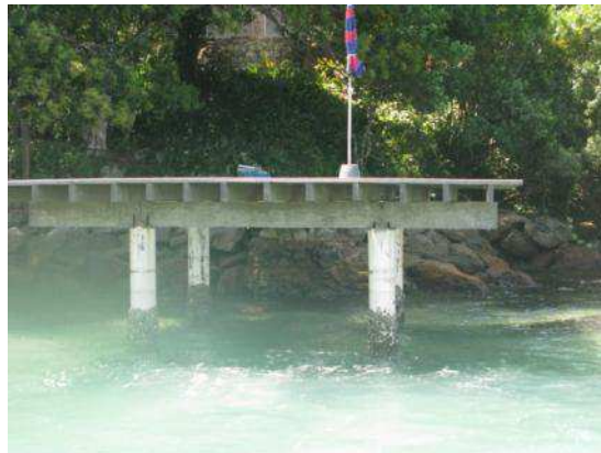
Figura 47 Deck sobre pilotis
