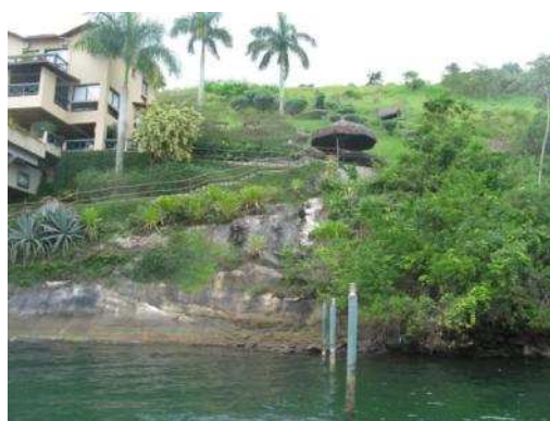
Figura 14 Linha de estacas para iluminação
