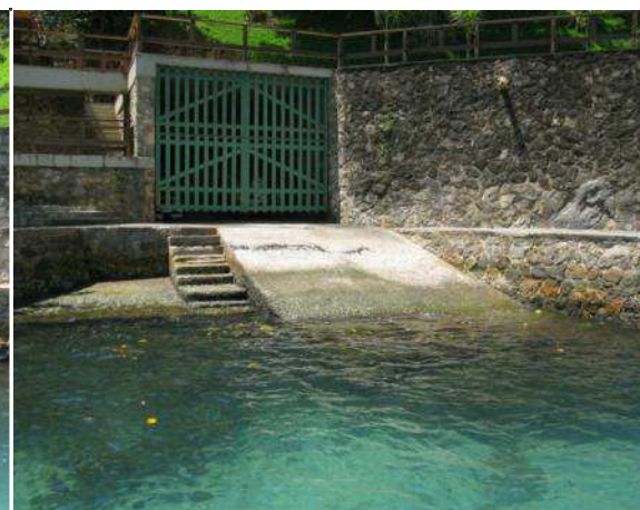
Foto 22: Rampa de acesso a garagem de barco
