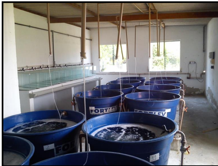
Figura 13 – Laboratório de Piscicultura marinha da EEAAPM – sistema de recirculação de água.
